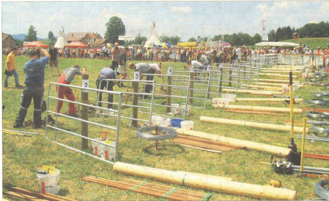
An der Zaunbaumeisterschaft vom 26. August gilt es einen 70 Meter langen Elektrofestzaun zu erstellen, drei Drähte zu spannen und ein Weidetor zu montieren. (Bild: Silvia Giger)
